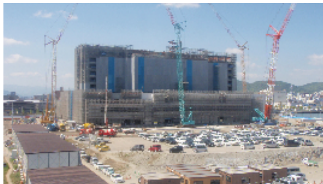
工事現場状況(H25.5.13時点)
